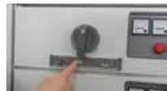
将移动钮左拨，闭锁解锁钮和摇杆孔
